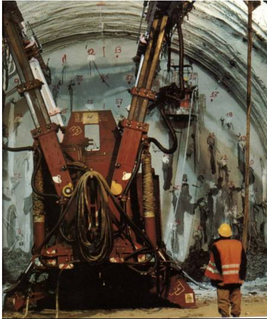
Fig.1 Preconsolidamenti del fronte (posizionatore)
